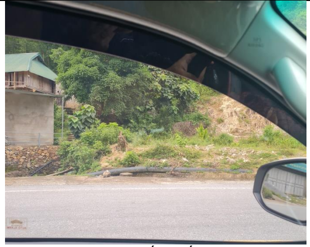
Hiện trạng đường ống cấp nước thô qua xã Thọ Ngọc
