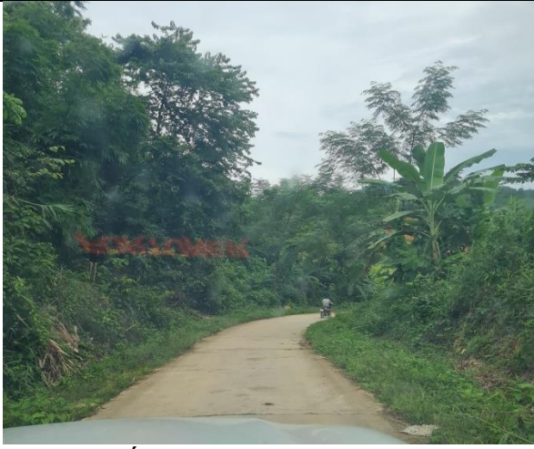
Tuyến đường liên xã qua dự án
